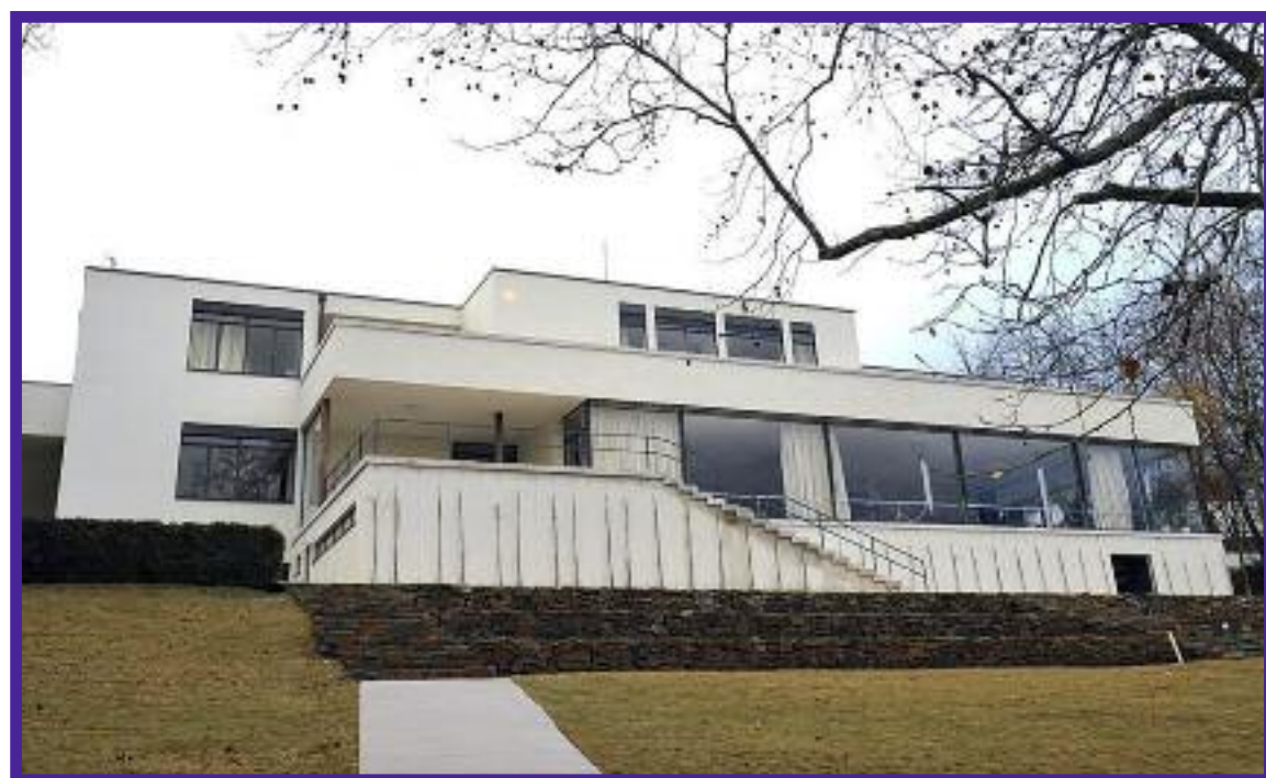
Vila Tugendhat po rekonstrukci.
